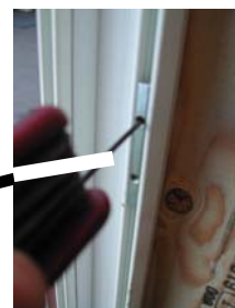
OBS! Kontroller at sluttstykkene kommer rett! Sett innenfra: høyre side; innerste spor, venstre side; ytterste spor.
